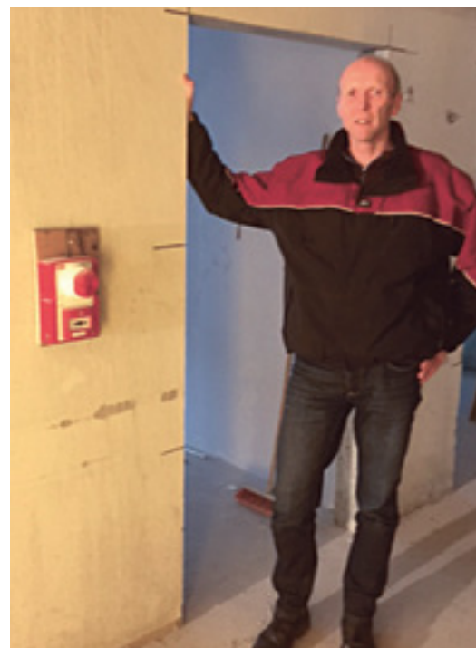
Foto: Lom kommune Kåre Frydenlund ved en av enhetene til det trådløse brannalarmanlegget på helseheimen.
