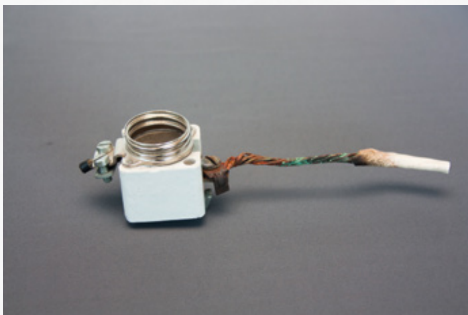
Varmgang i skrusikring.
